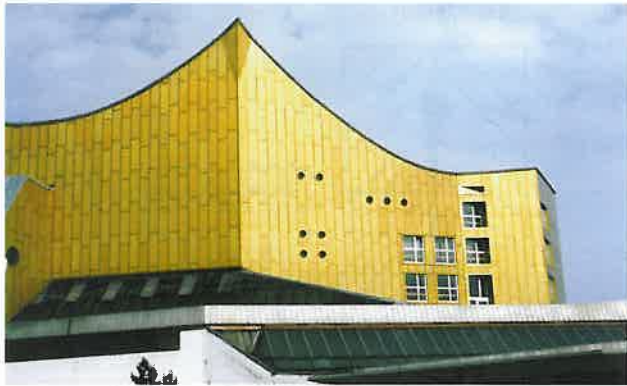
Abb. 10: Philharmonie Berlin, GF-UP-Fassade
