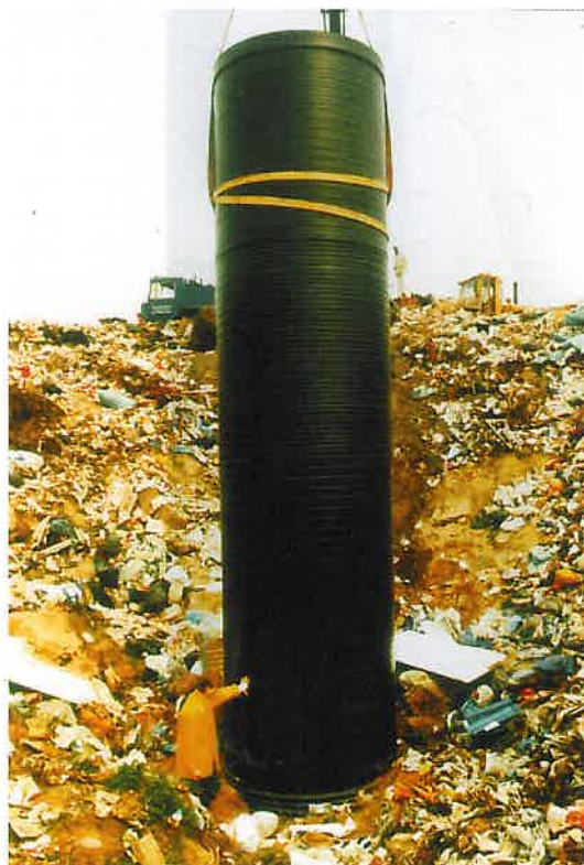
Abb. 18: Kondensatschächte in Mülldeponien aus HD-PE. Deponietiefe \leq 25 m. Nachweisführung: axiales und radiales Beulen mit Überlagerung, allgemeine stat. Berechnung mit lokalen Spannungsanalysen.
