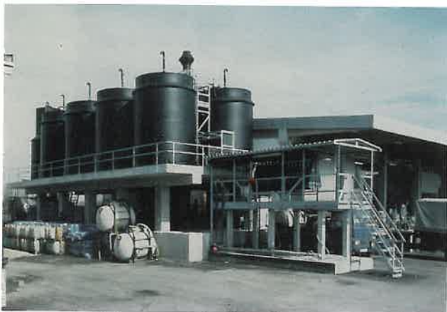
Abb. 19: Lagerbehälter aus Polyethylen. Hergestellt im Wickelverfahren.
