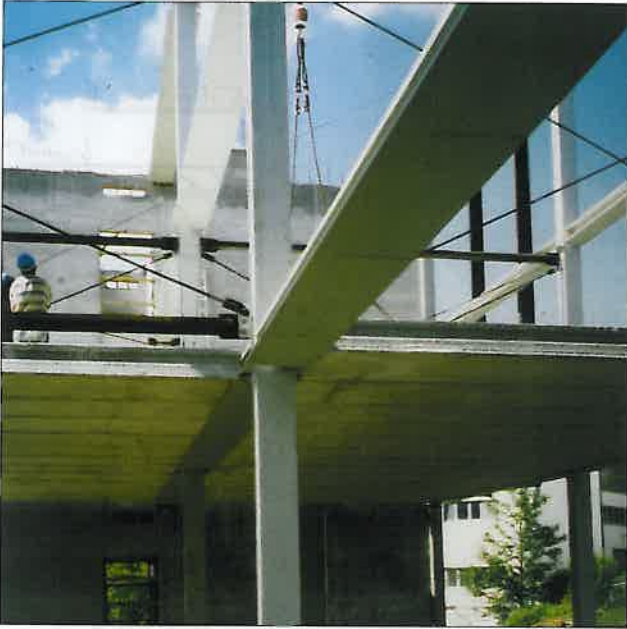
Abb. 5: Technologie-Park Bergisch Gladbach, Haus 50/51: montierte Spannbetonhohldielen mit Stahlflachträgern
