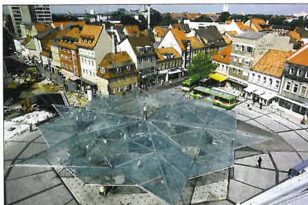
Abb. 1: Überdachung Roßmarkt in Schweinfurt
