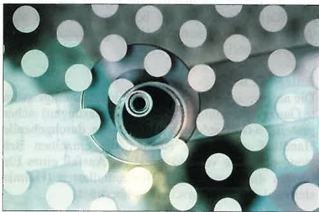
Abb. 10: Toleranzproblem bei Durchsteckmontage von Punkthaltern (Alle Fotos: R. Danz, 71101 Schönaich)
