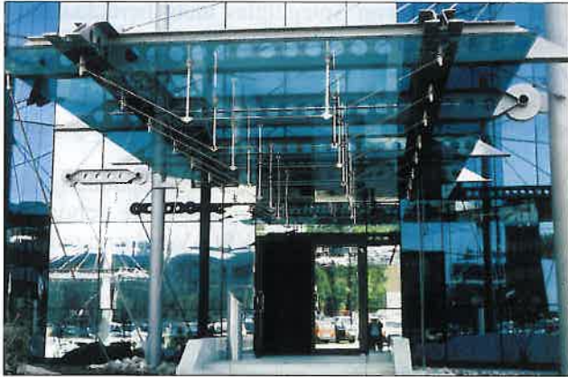
Abb. 4: Punktgestützte, unterspannte Vordachverglasung eines Verwaltungsgebäudes
