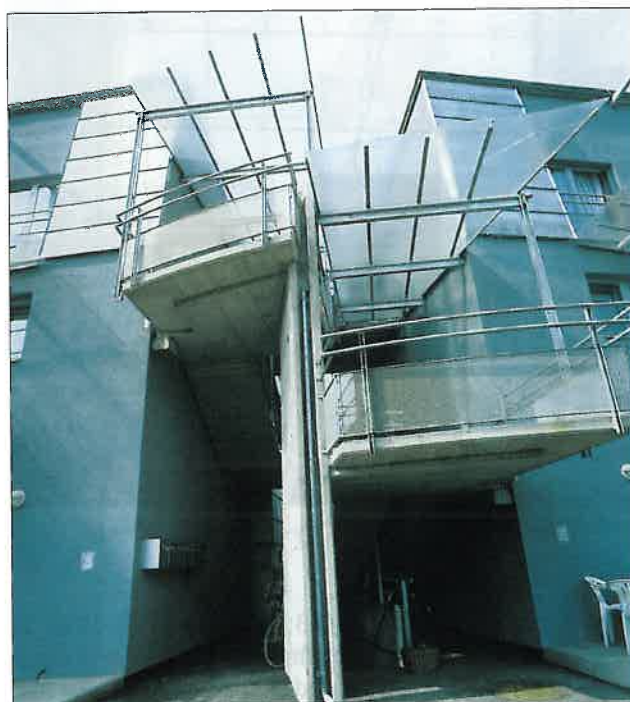
Abb. 3: Überkopfverglasung eines Gebäudezugangs mit Drahtglas
