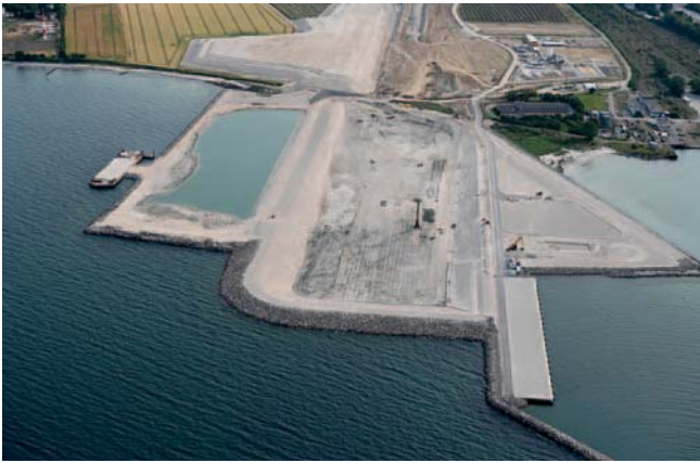
Abb. 17: Luftbild des Übergangsbereichs auf Fehmarn im Juli 2023
