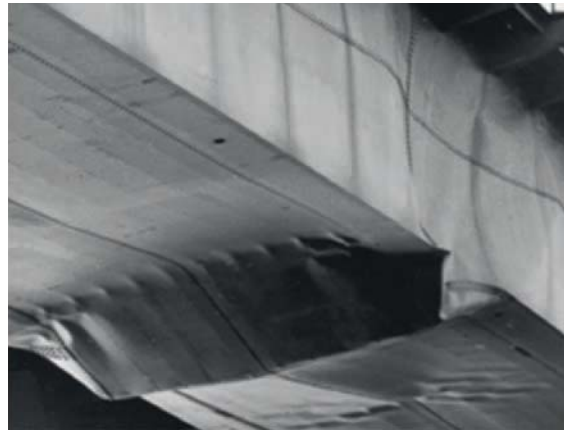
Abb. 7: Praterbrücke Wien: Knick im Untergurt des Kastenträgers infolge lokalen Stabilitätsversagens
