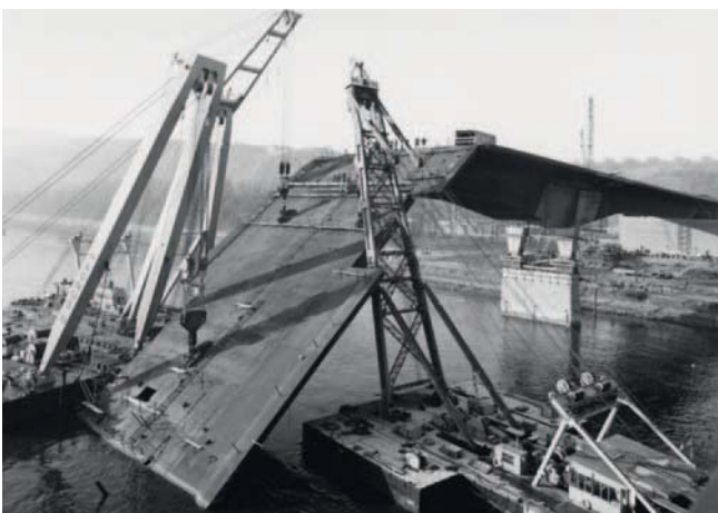
Abb. 10: Einsturz der Rheinbrücke Koblenz durch Stabilitätsversagen des Untergurts des Kastenträgers
