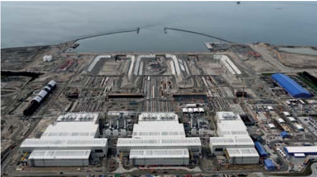
Abb. 9: Luftbild der Tunnelfabrik, der Schleusen und des Arbeitshafens.
