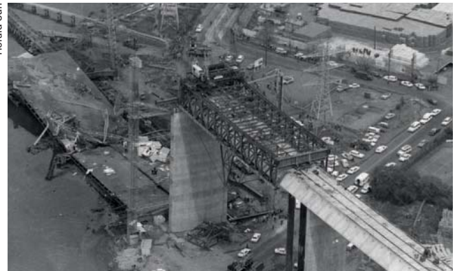
Abb. 9: Einsturz der West Gate Bridge in Melbourne durch Stabilitätsversagen des Untergurts des Kastenträgers
