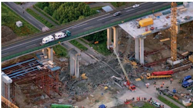
Abb. 3: Einsturz des Traggerüsts für den Ersatzneubau der Talbrücke Schraudenbach am 15. Juni 2016
