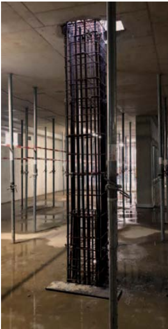
Abb. 5: Wiederaufgebaute Stütze auf Grund geänderten Lastabtrags
