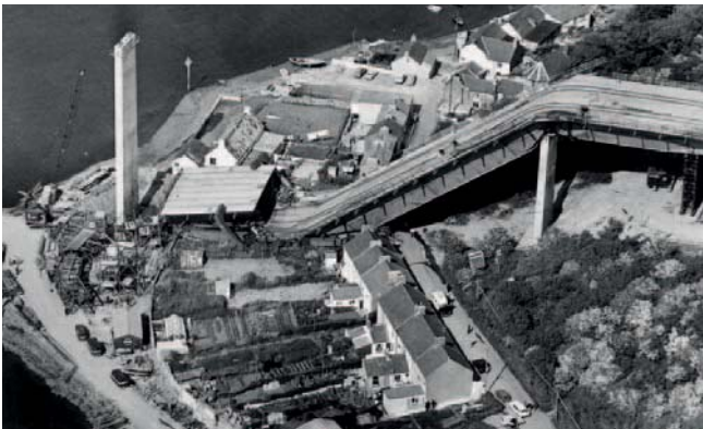
Abb. 8: Einsturz der Cleddau Bridge in Pembrokeshire in Großbritannien durch Stabilitätsversagen des Untergurts des Kastenträgers
