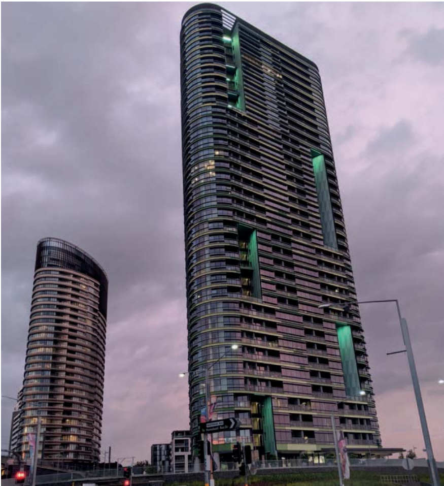
DIESES GEBÄUDE – der Opal-Tower in Sydney – ist für eine gefährlich-desaströse fehlerhafte Tragwerksplanung und für die Verwendung nicht geeigneter und qualitativ minderwertiger Baustoffe bekannt geworden – was letzten Endes der auslösende Faktor für die Gründung des Internationalen Zentrums für Bauqualität IPQC war.
